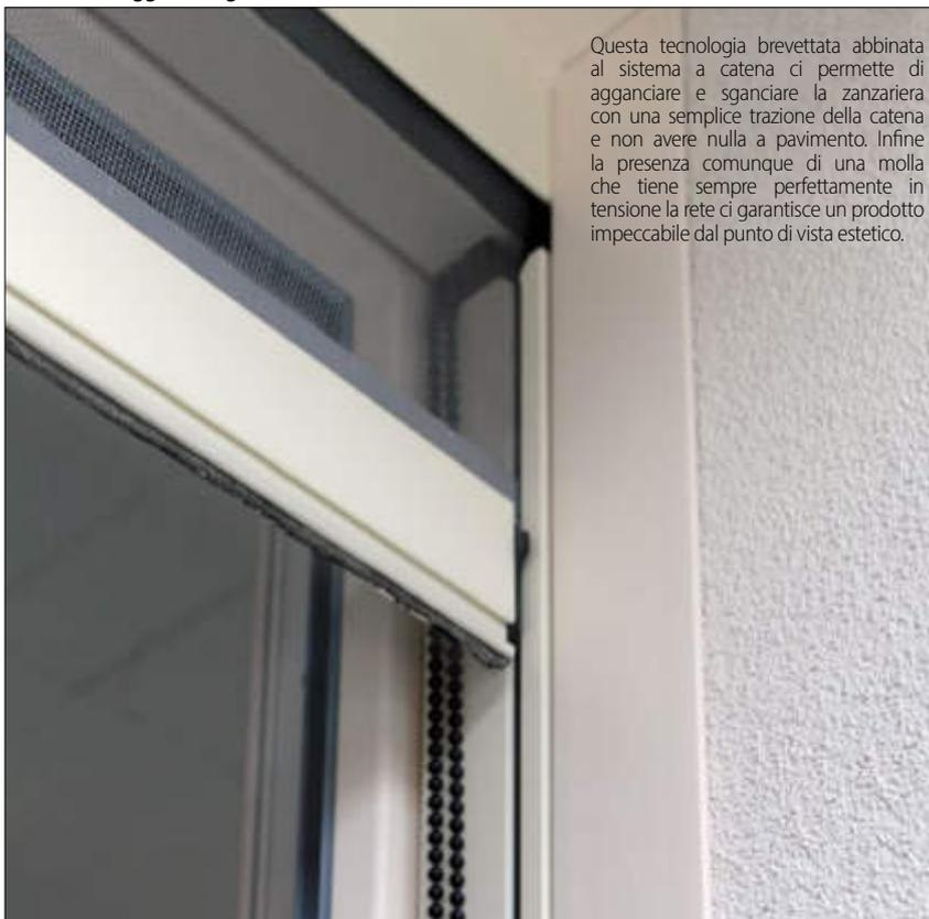
Questa tecnologia brevettata abbinata al sistema a catena ci permette di agganciare e sganciare la zanzariera con una semplice trazione della catena e non avere nulla a pavimento. Infine la presenza comunque di una molla che tiene sempre perfettamente in tensione la rete ci garantisce un prodotto impeccabile dal punto di vista estetico.
